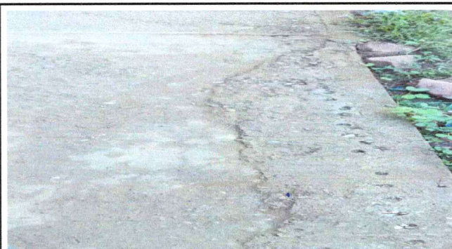
Foto 6: Se observa el deterioro del corredor de la escuela del modulo 1.
